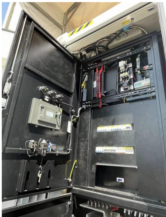
内部（PowerCube-20H-M7A200C5.015-EU-05 电池系统）
